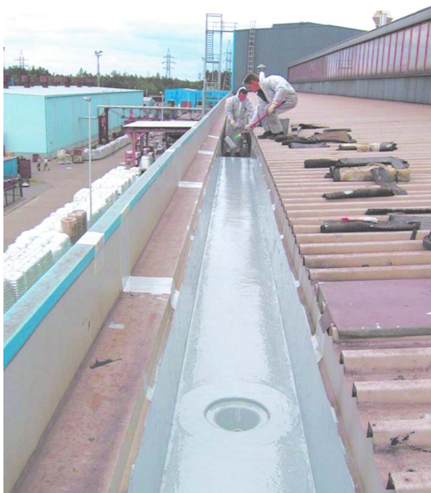
Гидроизоляция стока на Заводе холодильников «Стинол» (г. Липецк) с использованием материалов, предлагаемых компанией «Полимер Про»
