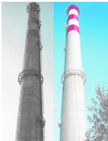
Железобетонная труба до (слева) и после (справа) обработки композицией «Галокор»
